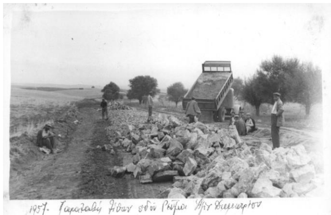
Κατασκευή αγροτικού δρόμου στο ρέμα του Αγ. Δημητρίου (1957)
